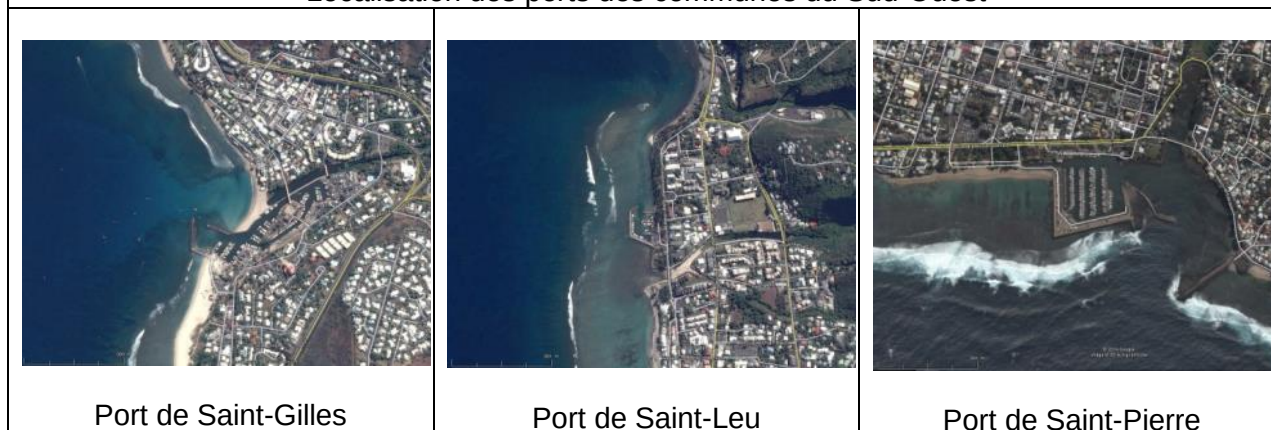
Figure 13 : Localisation des ouvrages portuaires étudiés (Google Earth 2016)
