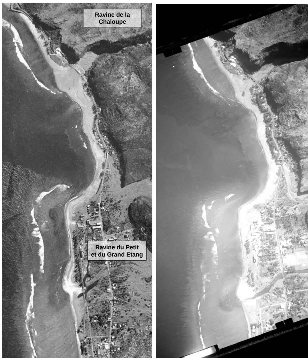
Figure 20 : Situation du port de Saint-Leu en 1950 (à gauche) et 1966 (à droite) – source ©IGN
