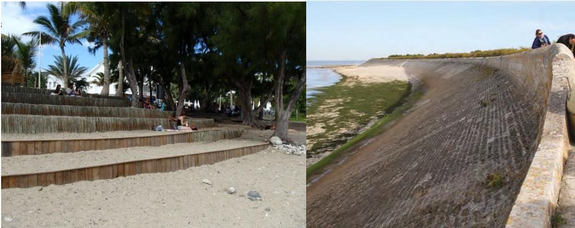
*Illustration 43 : **A gauche**, Exemple d'aménagement en « marche d'escalier » composé de fascines en bois (Campagne IMOCOR, SPA 035), **A droite**, Exemple de digue inclinée à Loix, île de Ré, pouvant permettre de dissiper l'énergie des vagues lors des tempêtes (Forray, 2017)*
