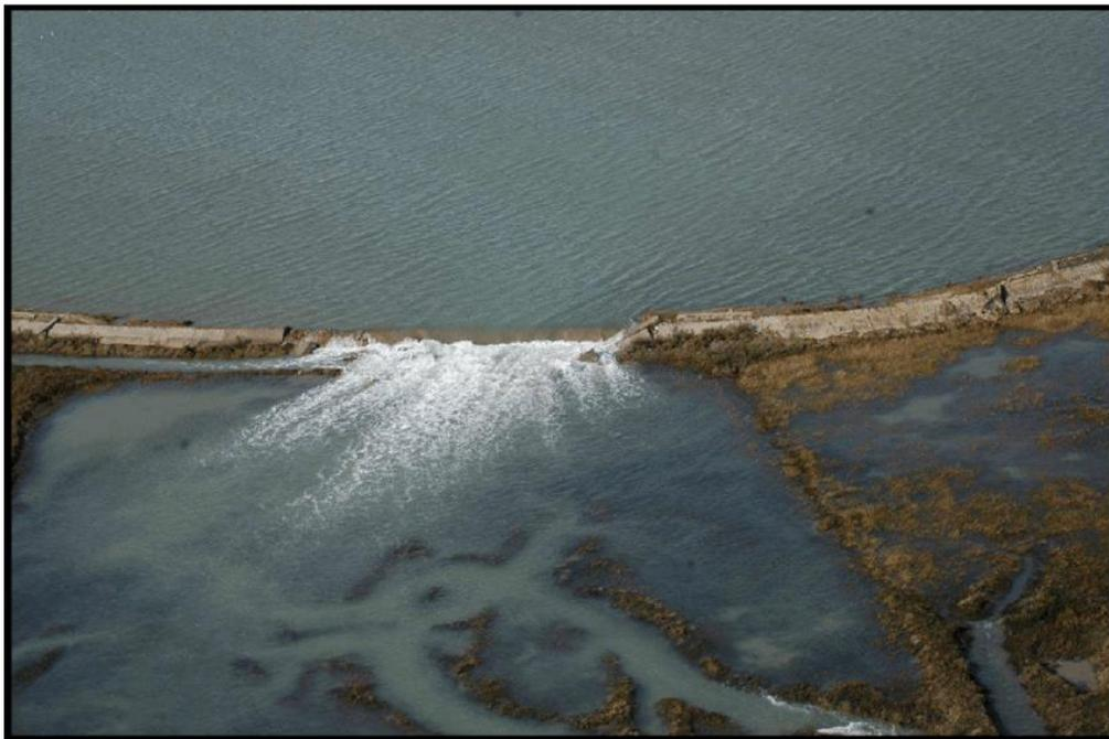
Illustration 8 : Illustration d'une submersion par rupture de digue suite à la tempête Xynthia. (Photo: CG17)
