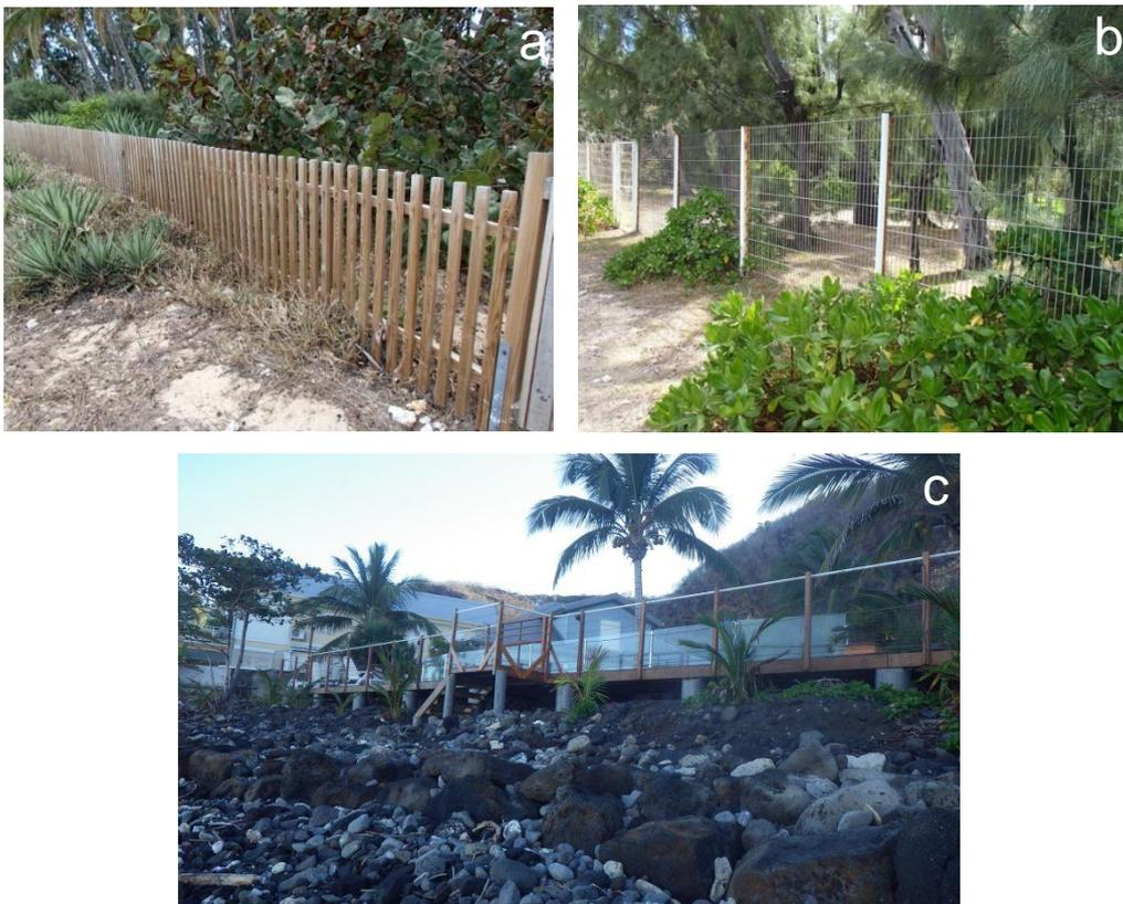
*Illustration 42 : Exemples d'aménagement, a) de clôture, b) de grillage, c) d'ouvrage sur pilotis, dont la transparence hydraulique est forte, limitant l'obstruction des transferts sédimentaires (Campagne IMOCOR, respectivement SPA132, SPA 139 et SLE21).*
