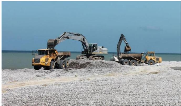
Illustration 30 : **A gauche**, rechargement de sable sur la plage de Hauteville-sur-Mer (photo : Tp Boutté) ; **A droite**, rechargement de galet sur la plage de Mers-les-Bains (photo : ville de Mers-les-Bains)
