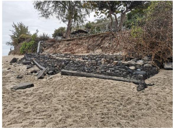
*Illustration 14 : **A gauche**, exemple d'affouillement en pied d'ouvrage suite à un évènement de houles australes à l'été 2020 (plage des Roches Noires) ; **A droite**, basculement d'un ouvrage suite à un évènement de houle australe en 2019 (plage des Roches Noires).*
