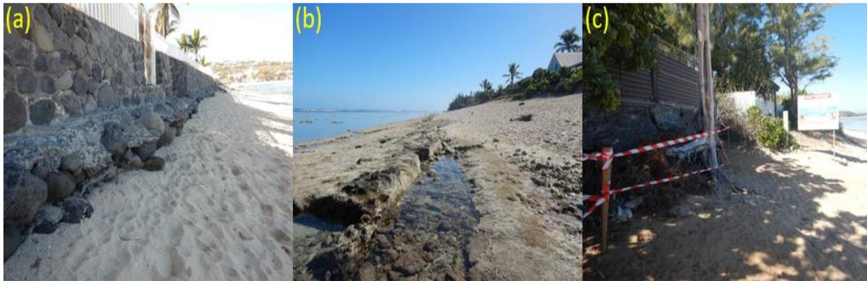
Illustration 14 : Constats d'érosion observés sur la CH 1 (a: affouillement au pied d'un mur, b : mise à nu du beachrock suite à une perte de sable, c : déracinement d'un filaos et instabilité d'un mur suite à une perte de sable) (Photos BRGM 2020)
