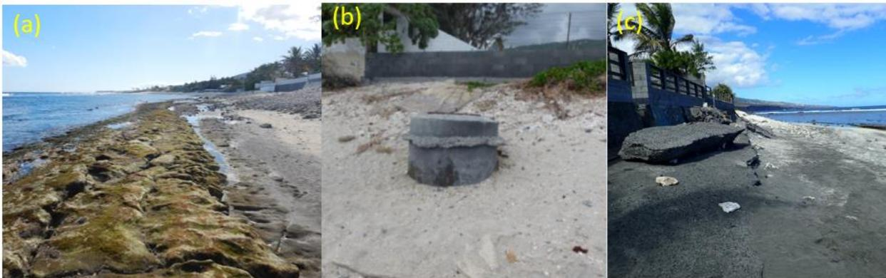
*Illustration 45 : Photographies réalisées sur le linéaire côtier de Trois-Bassins, attestant de l'érosion côtière sur le secteur ( a : mise à nu du beach-rock, synonyme d'une perte de sédiments ; b : regard d'égout, témoin de la l'abaissement de la topographie de la plage ; c : sol bétonné détaché suite à un affouillement)*
